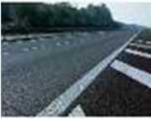
Figure 33: Béton bitumineux source : Darul 2012
