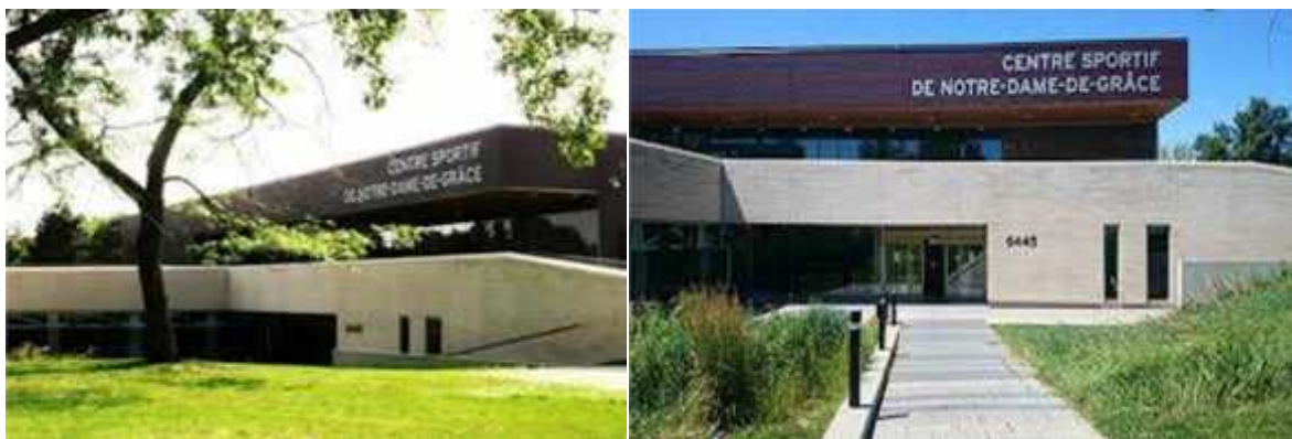
Figure 8: vue sur la façade principale du complexe source: Duhamel, 2011
