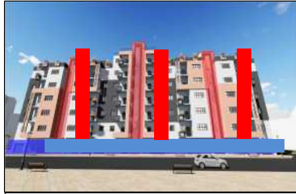
Fig 22 (III.5): La verticalité et l'horizontalité de la façade des barres nouvelles Source : Auteurs 2017
