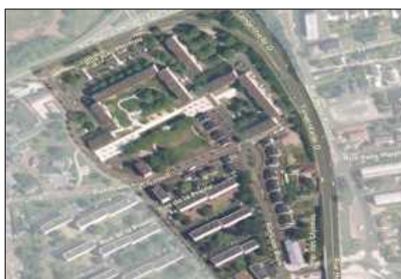
Fig 10 (II.3) :Photo aérienne montrant la situation de quartier Salmoneries Source : https://www.google.dz/maps/place/Allée+de+l+a+République,+45140+Saint-Jean-de-la-Ruelle,+France
