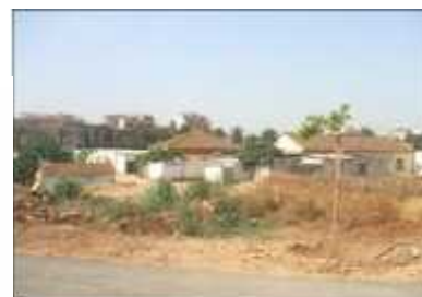
Fig11 (III.2): Photo de quartier Mahmoud Source :Auteurs 2017
