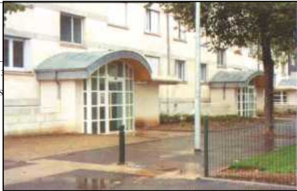
Fig 5 (II.3) : Halls d'entrée créés lors des travaux d'amélioration (photographie du CETE de Normandie Centre ,2002)
