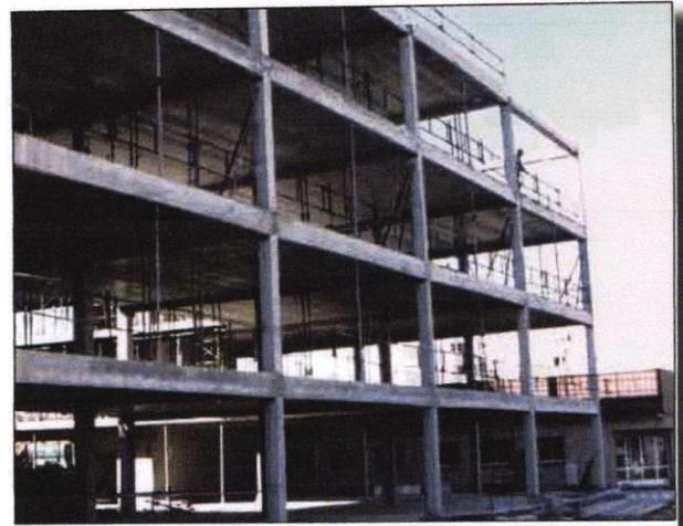
Fig: Exemple d'un immeuble en structure poteau-poutre
