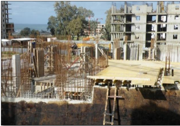
Figure 27(2.3) : Travaux de coffrage et coulage des dalles Srcce : http://www.pimb-dz .
