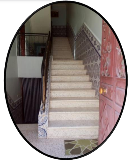
FIG 139 : Escalier Source : l'auteur
