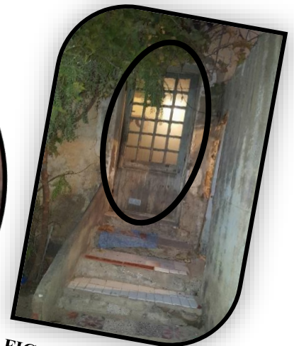
FIG107 :accès à la cour Source : l'auteur
