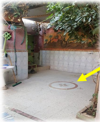
FIG 63 : Cour d'une maison traditionnelle Source : l'auteur
