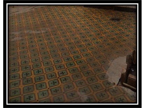
FIG 86: Revêtement du sol Source : l'auteur
