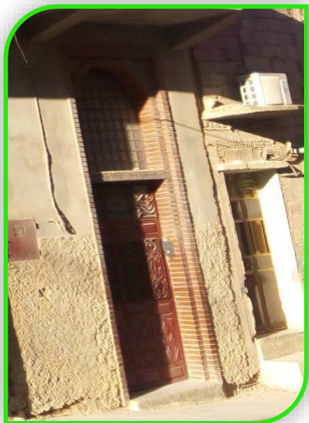
FIG 128 : l'accès de la maison Source : l'auteur
