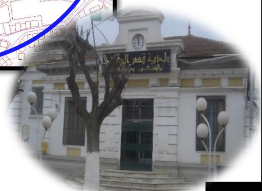
FIG 96 : APC de ksar el boukhari
