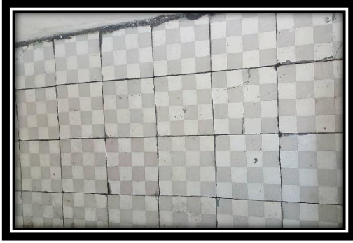
FIG 85: Revêtement du sol Source : l'auteur
