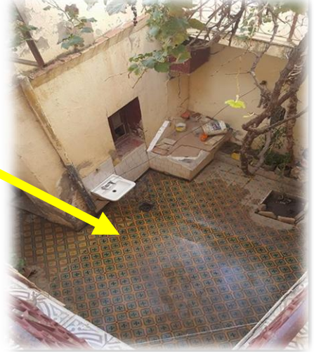
FIG 65 : Cour d'une maison traditionnelle Source : l'auteur
