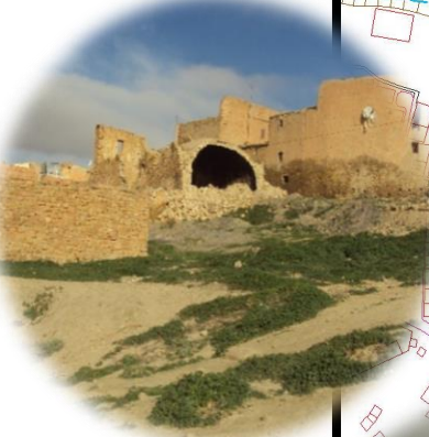
FIG 42 : Vue de l'ancien bain de ksar Source : l'auteur
