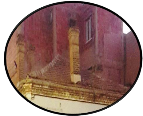
FIG104 :Toiture inclinée Source : l'auteur
