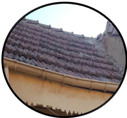
FIG103 :Toiture inclinée Source : l'auteur
