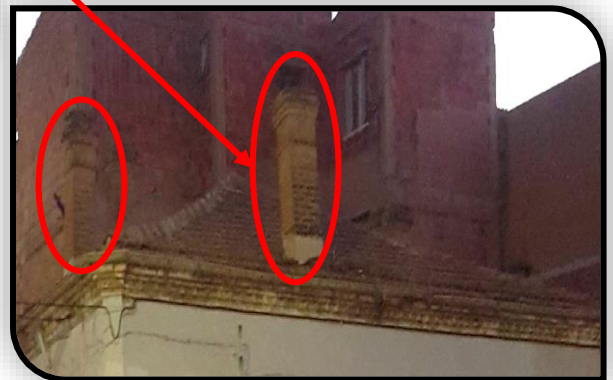
FIG 100 : Une gaine de cheminé Source : l'auteur
