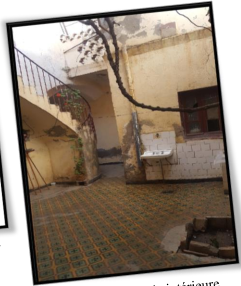
FIG 74: Façade intérieure Source : l'auteur
