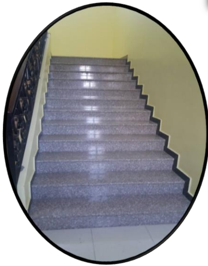
FIG 138 : Escalier Source : l'auteur
