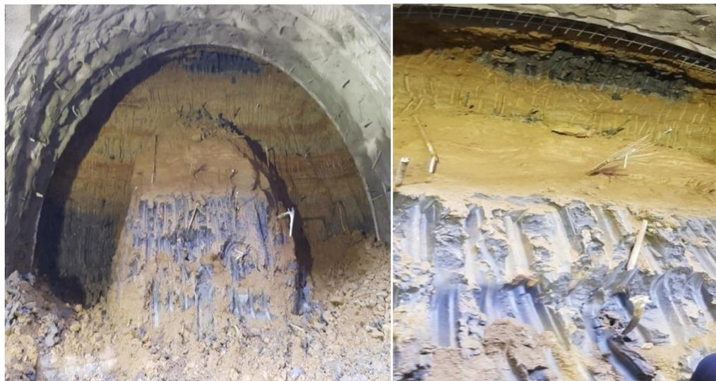
**Figure II.17: Exemple de renforcement de sol par les boulons des fibres de verre.**
