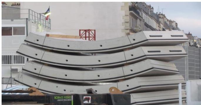
**Figure II.13:Exemple des voussoirs préfabriqué.**
