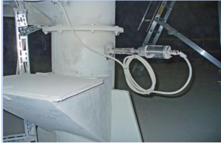
Figure A.11 Capteur de Débit.
