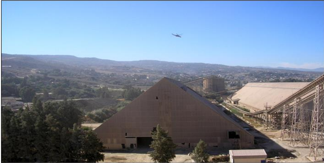
Figure 1.7 Hall de pré homogénéisation.
