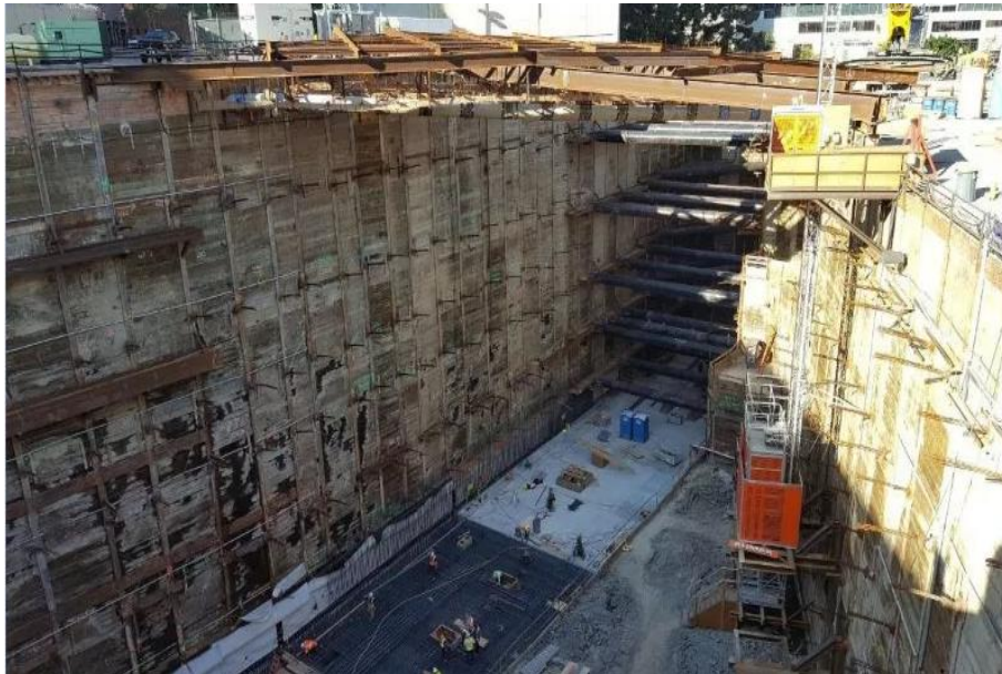
Figure I. 4 : Excavation ancrée. [1]
