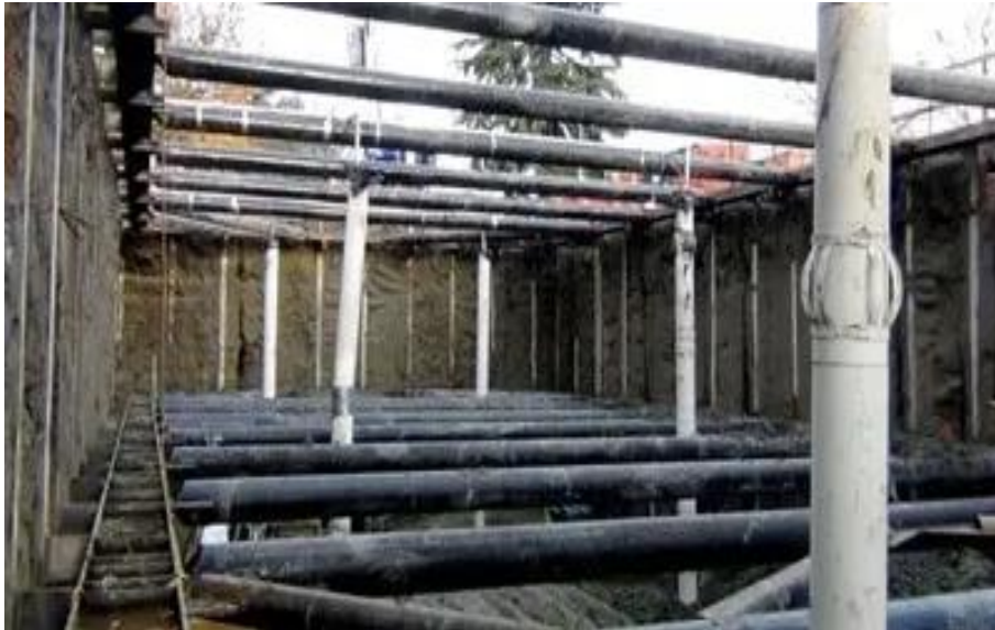
Figure I. 3: Excavation par contrepoids.[1]
