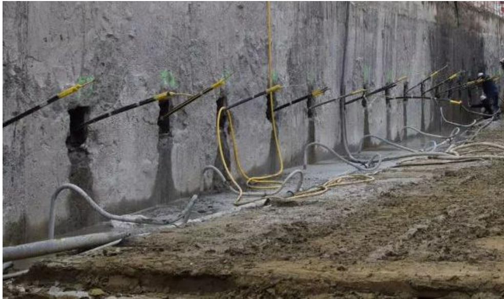
Figure I. 15 : Installation des tirants d'ancrage.
