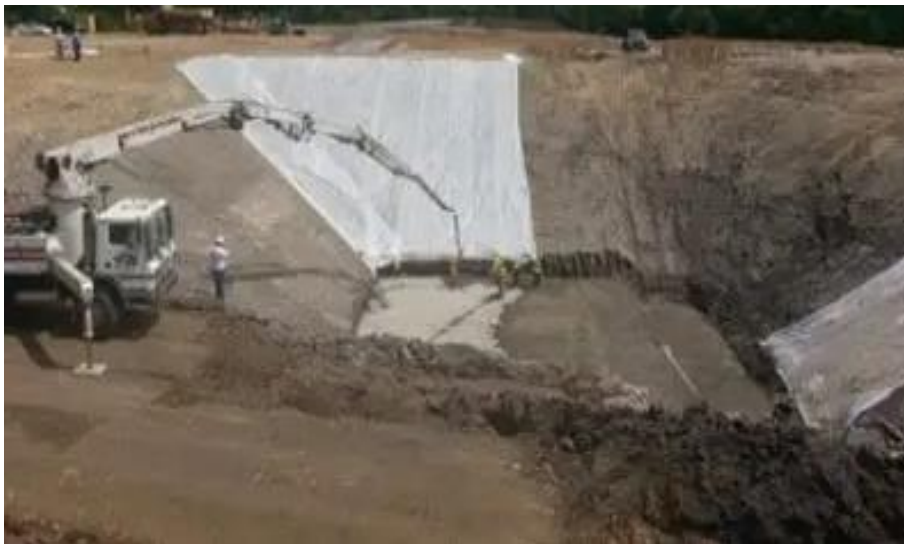
Figure I.1 : Excavation à ciel ouvert avec pentes latérales. [1]
