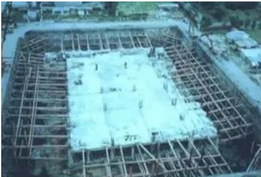
Figure I. 6: Méthode d'excavation des îles. [1]
