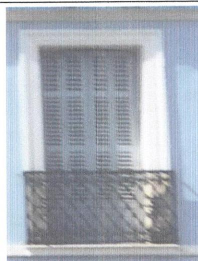
Une simple ouverture de forme rectangulaire avec balcon de fer forgé, on marque l'absence des corniches sous le balcon
