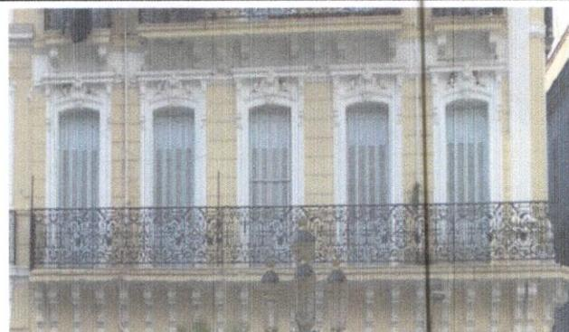
Cinq ouvertures de forme rectangulaire surélevées d'un arc surbaissé encadrées de moulures et surélevées par des sculptures assemblées par un balcon le long de l'étage, on marque l'existence des consoles sous le grand balcon.
