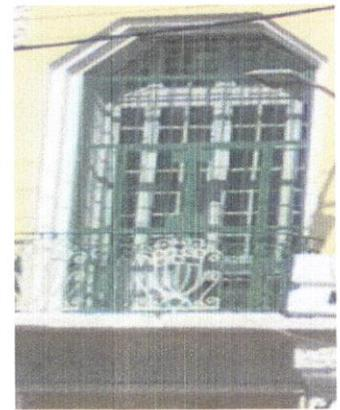
Une ouverture de forme rectangulaire surmontée par un arc brisé, encadré de deux moulures avec balcon de fer forgé porté par des consoles.
