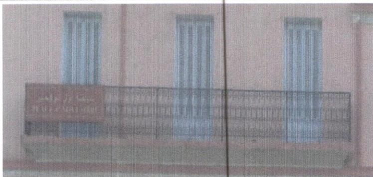
Trois ouvertures de forme rectangulaire sans décoration assemblées par un balcon le long de l'étage, on marque l'absence des consoles sous le grand balcon.
