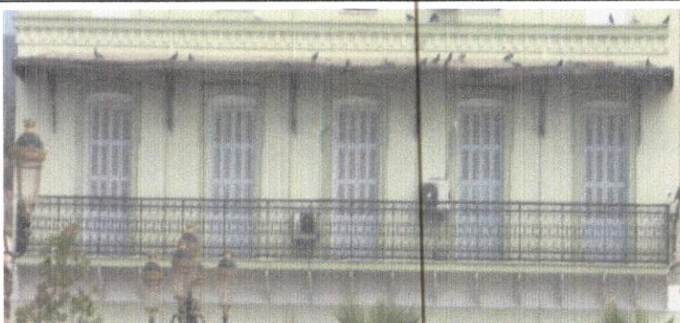
Série d'ouvertures alignées de forme rectangulaire avec un quadrillage ayant une arcature surbaissée qui marque la baie. Ces ouvertures sont assemblées par un balcon sous lequel sont construites des corniches.
