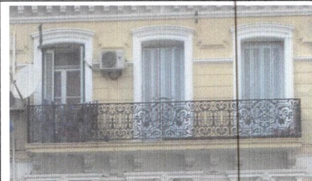
Trois ouvertures de forme rectangulaire surélevées d'un arc surbaissé et encadré de moulures sont assemblées par un balcon le long de l'étage, on marque l'existence des consoles sous le grand balcon.
