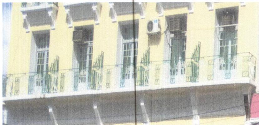
Cinq ouvertures de forme rectangulaire assemblées par un balcon le long de l'étage, on marque l'existence des consoles sous le grand balcon.
