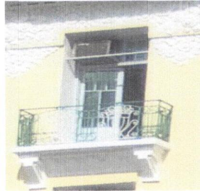
Une ouverture rectangulaire surmontée d'un tableau sculpté sous forme d'empreinte. Ce décor souligne la baie, la corniche et le balcon. Un balcon de fer forgé porté par des consoles avec des moulures.
