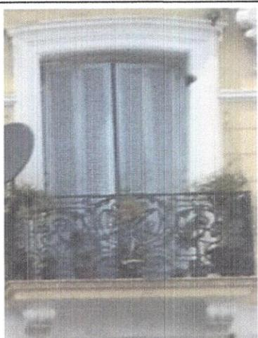
Une ouverture de forme rectangulaire surélevée d'un arc surbaissé doté d'un encadrement à moulure avec balcon de fer forgé, une décoration très importante. Présence de consoles sous le balcon.
