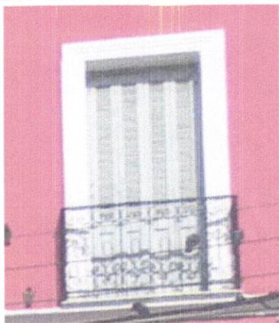
Une ouverture de forme rectangulaire encadrée de moulures avec balcon de fer forgé, on marque l'absence des consoles sous le balcon
