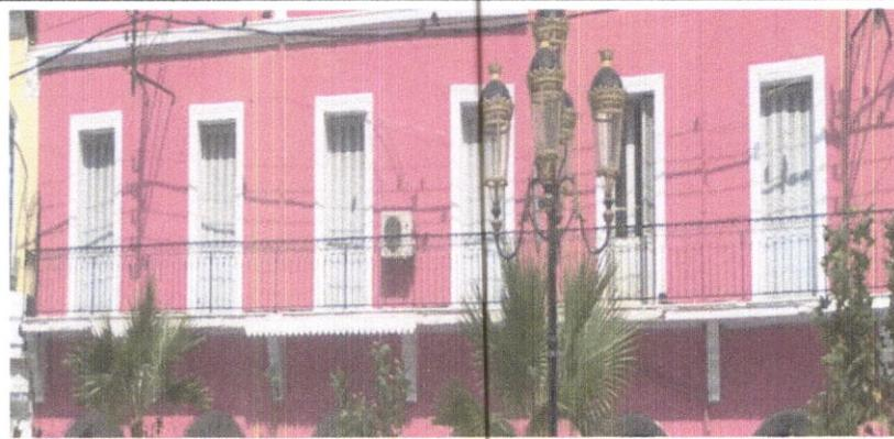
Quatre ouvertures de forme rectangulaire encadrées par des moulures assemblées par un balcon le long de l'étage, on marque l'existence des consoles sous le grand balcon.
