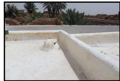
Fig.2.11.Puit de Ventilation
