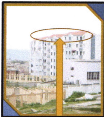
Charpente classique (toiture en tuile)
