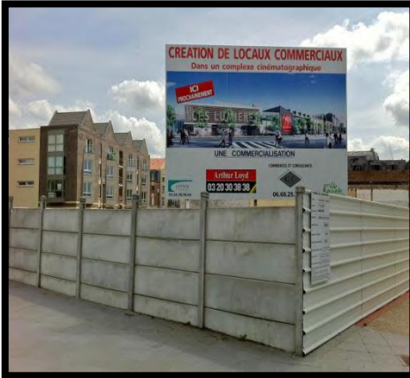
la Friche avant construction du pôle Cinéma. source: Réaménagement du quartier de la gare d'Armentières
