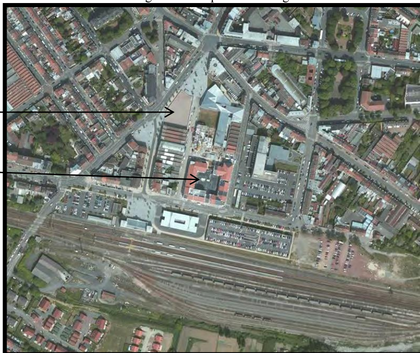
Terrassement « cinéma , commerces »et Construction « pôle lumière » en 2011 source: Réaménagement du quartier de la gare d'Armentières
