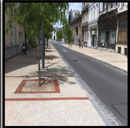
Requalification de la Rue de la gare en voie bus et liaison piétonne avec le centre-ville source: Réaménagement du quartier de la gare d'Armentières
