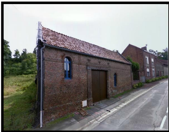
constructions initiales démolies source: vers-sur-selles.pdf
