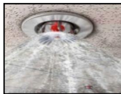
Figure 85: Extincteur automatique
