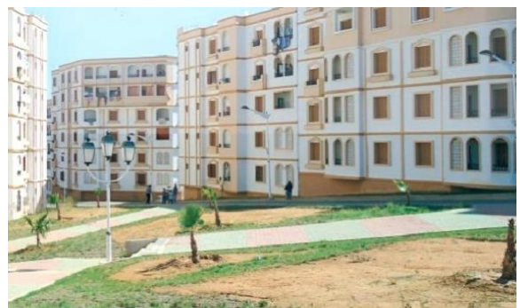
Figure 2.10: la cité 630 logements OPGI Oran. Source : Google image
