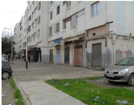
Figure 1.18 : Commerces en RDC à la Soummam. Source : Google image
