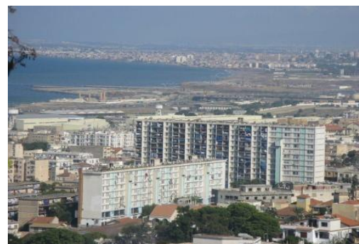
Figure3.70 : Exemple des grandes ensembles, la cité Amérouche à Hussein-Dey.
