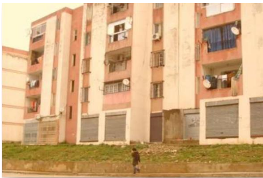
Figure 2.9: la cité 328logements OPGI Jijel. Source : Google image
