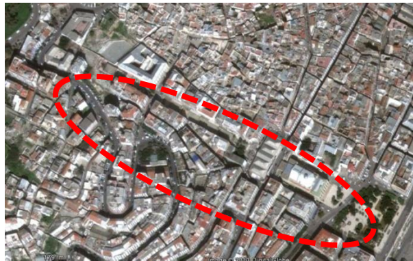
Figure3.37 : Boulevard Ourida Meddad vue de ciel.
