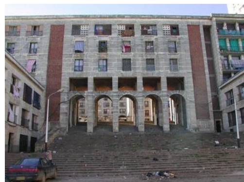
Figure3.73 : façade donnât sur la rue. Source : Google image Traitée.
