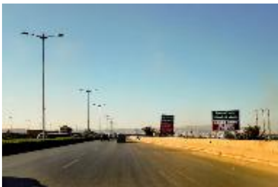
Figure3.4 : Autoroute N11 Mohammedia
