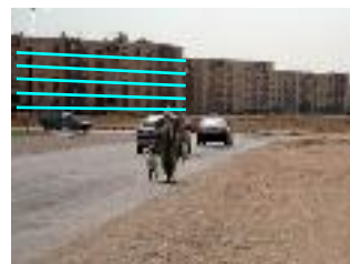
Bâtiment à gabarit R+5
