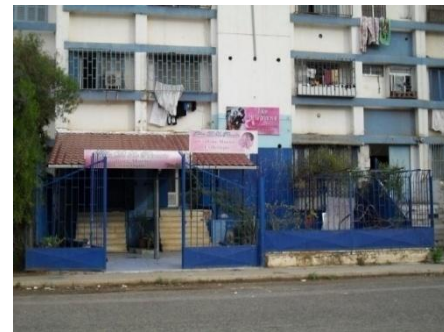
Figure 1.19 : Aménagement d'une entrée publique pour un appartement en RDC servant de fonds de commerce (salon de coiffure). Source : Google image
