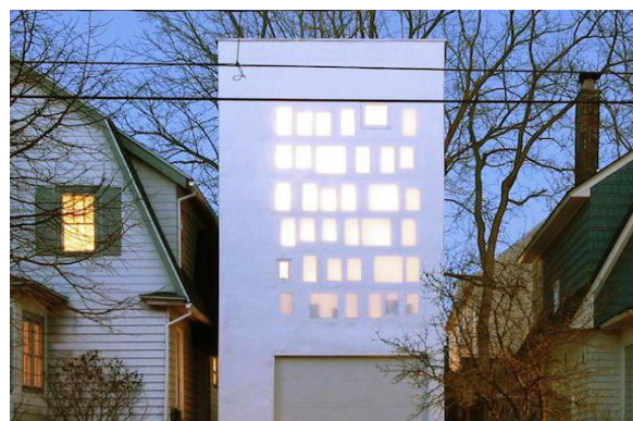
Figure 34: La maison Haffenden Source : designboom.com
