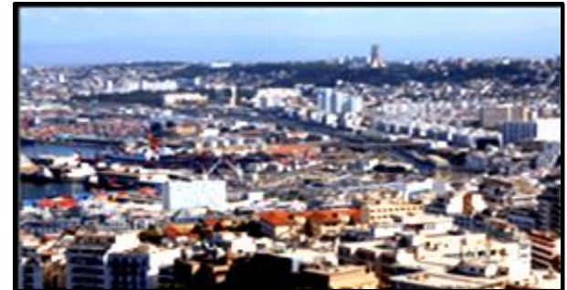
vue sur le port d'Alger Srcce : pdau d'Alger 2010
