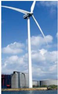
RÉDUCTION DES BESOINS ÉLECTRIQUES
