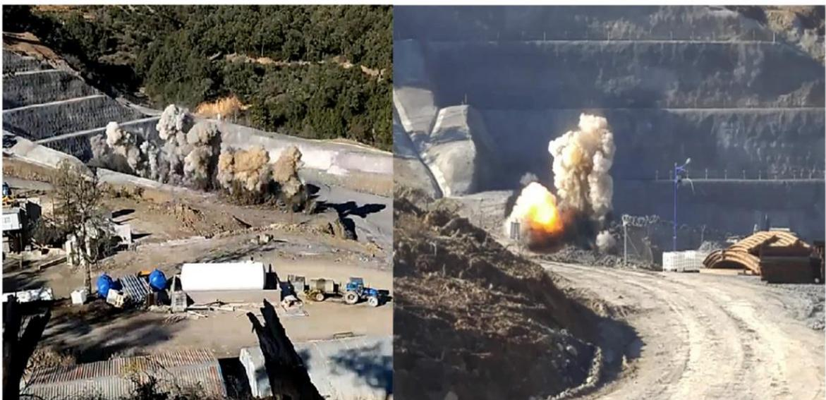
Figure II.1. Explosif utilisé sur le portail d'un tunnel
