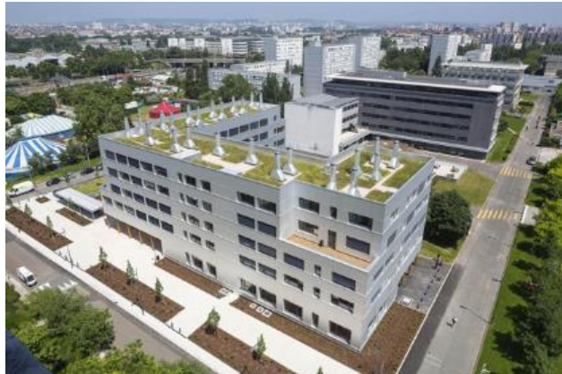
Figure II.29 .Vue arienne sur le bâtiment Source : http://conseils.xpair.com/
