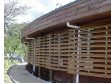
Figure II.14.Des installations pour l'eau pluviale Source : http://conseils.xpair.com
