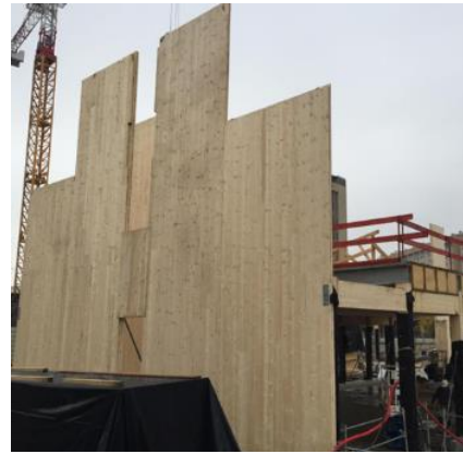
Figure II.33. Panneau préfabriqué en bois Source : http://conseils.xpair.com/
