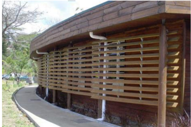
Figure II.28 .Traitement des façades Source : http://conseils.xpair.com
