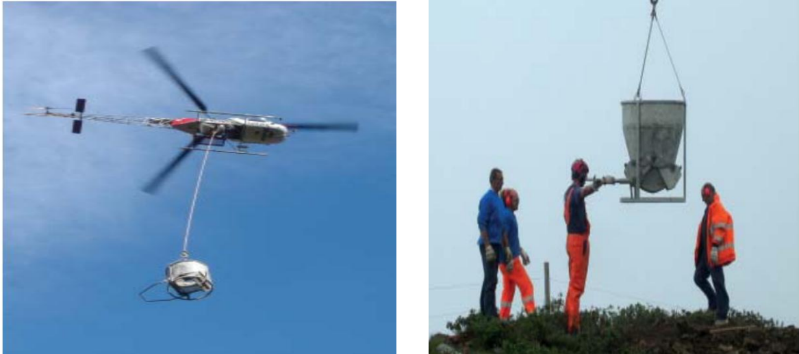
Figure II.9: Hélicoptère effectuer le transport d'une charge externe (construction).
