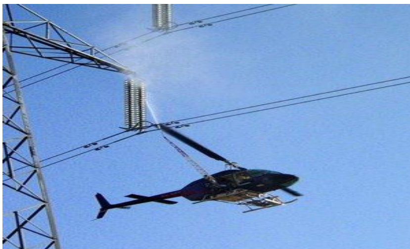
Figure II.10: Le lavage des isolateurs électriques par hélicoptère.
