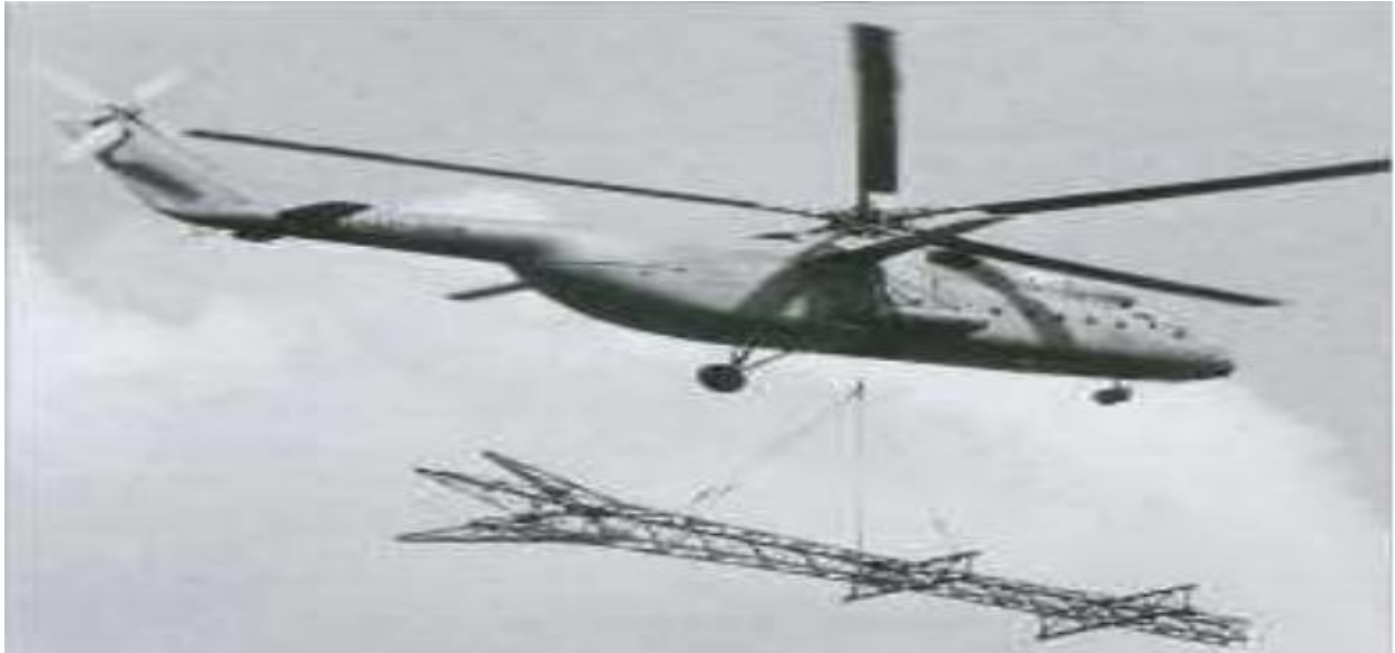
Figure I.7: Positionnement et montage de pylônes.
