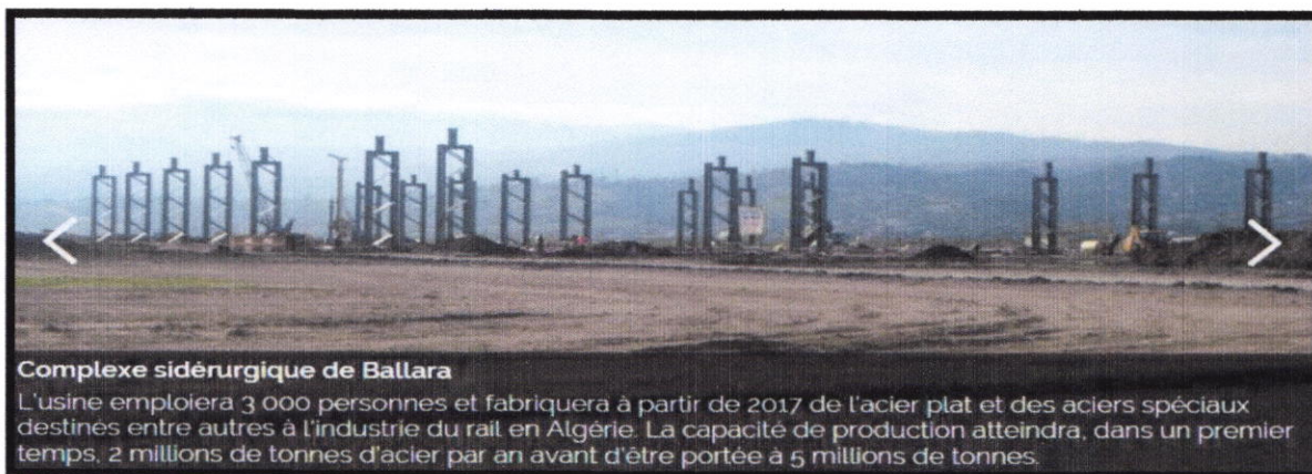
Figure II-13 : Chantier de complexe sidérurgique de Bellara
