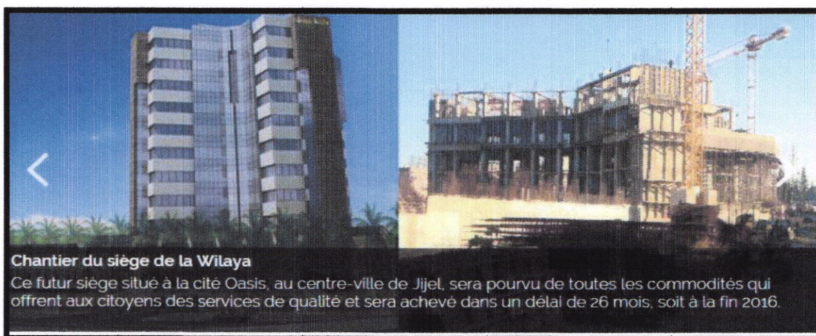
Figure II-12 : chantier du siège de la wilaya
