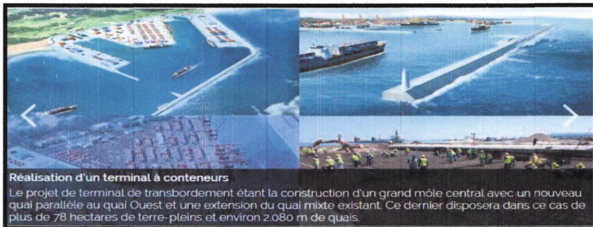
Figure II-11 : Réalisation d'un terminal à conteneurs
