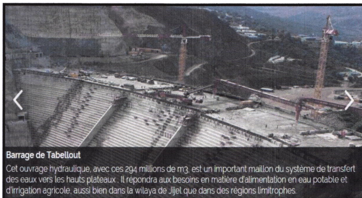
Figure II-8 : Barrage de Tabellout a on cour de réalisation –Jijel-
