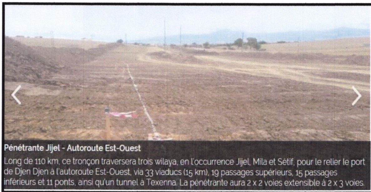
Figure II-9 : Les travaux d'Autoroute Est-ouest
