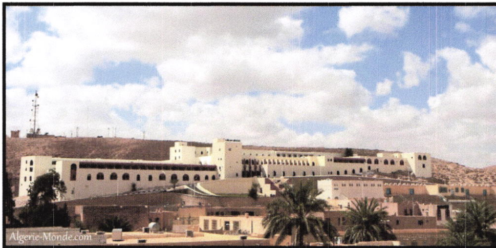
Fig.14: Vue sur Hôtel de MZAB (Ghardaïa), F. Pouillon architecte, 1974. Source : www.fernandpouillon.com/association.html/architecte/albums/Algérie/ghard-rostemide/index.html
