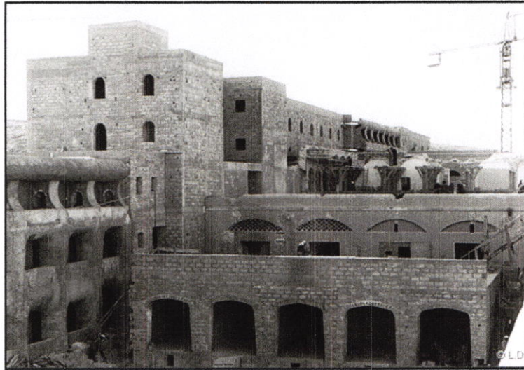
Fig.9: Vue sur le chantier de L'hôtel "MZAB" à Ghardaia F. Pouillon architecte. Source : www.fernandpouillon.com/association.html/architecte/albums/algerie/ghard-rostemide/index.html
