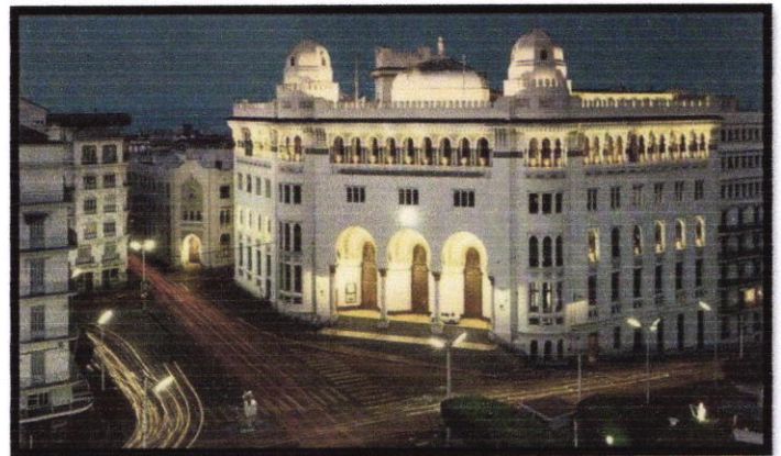
Fig.7 : La grande poste d'Alger.
