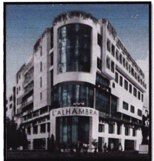
Fig.75 : L'Alhambra -Alger centre Source : prise par l'auteur sur chantier
