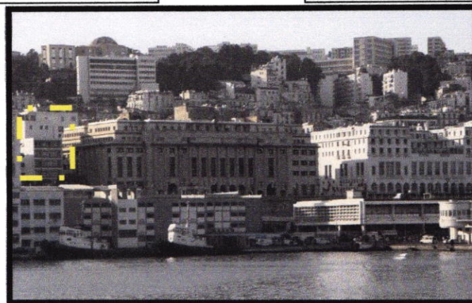
Fig.63 : situation du bâtiment DPAT d'Alger. Source : https://www.algerie-eco.com/wp-content/uploads/2017/09/apn-ext.jpg
