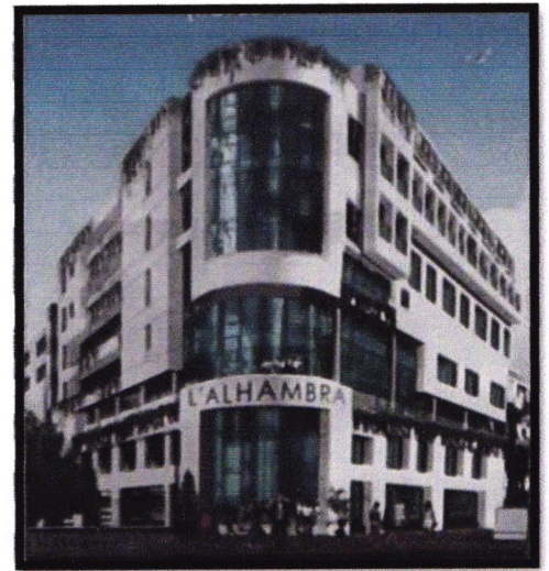
Fig.71 : L'Alhambra -Alger centre Source : prise par l'auteur sur chantier
