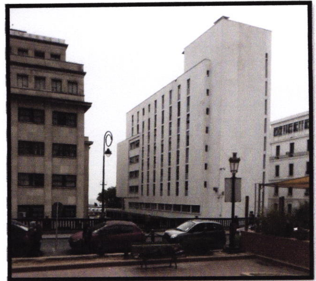
Fig.60 : le bâtiment DPAT d'Alger. Source : Prise par l'auteur
