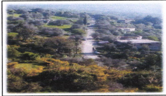
Photo 26 : Le Chemin de wilaya N°137.
