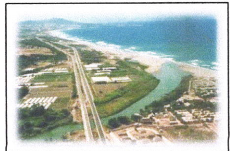
Photo 8 : ligne ferroviaire et RN°43.
