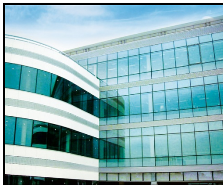
Figure18 : Mur rideau, c'est un mur de façade qui assure la fermeture de l'enveloppe du bâtiment sans participer à sa stabilité Source: https://www.google.dz/Fla-grande-motte-mer-beach
