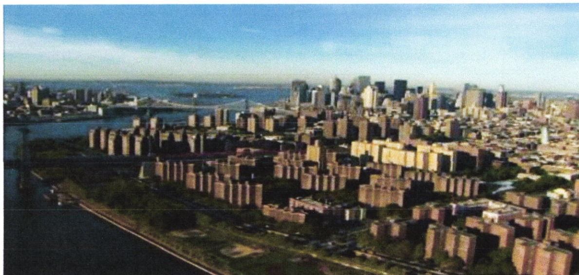
Figure 32 : Manhattan / New York City / Vue Aérienne / Etats-Unis http://footage.framepool.com/fr/shot/788869872-pont-de-manhattan-brooklyn-bridge-east-river-pont-routier
