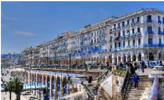
Figure 21: la façade blanche maritime; la baie d'Alger
