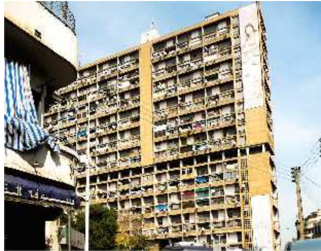
Figure 84: Aéro-habitat, Telemly, Alger (Algérie)
