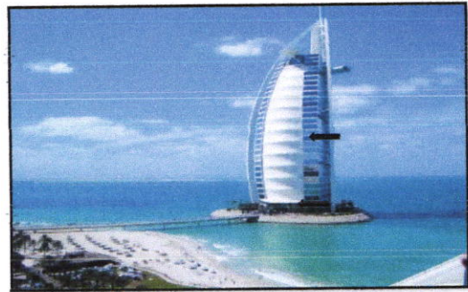
Figure 22. Orientation du bâtiment source : www.SlidePlayer.fr
