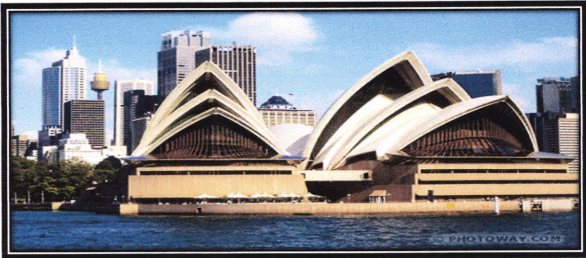
Figure 8 : Opéra de Sydney, Australie. Les grandes ouvertures pour l'éclairage naturel et la ventilation.
