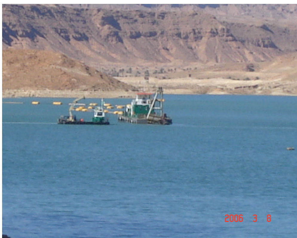
Figure 4.10 : Dragageuses suceuse refouleuse au cours de dragage du barrage de FOUM EL GHERZA.
