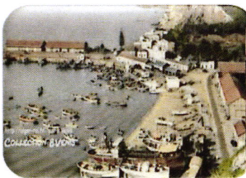
Figure 4:vue du port d'AZEFFOUN.
