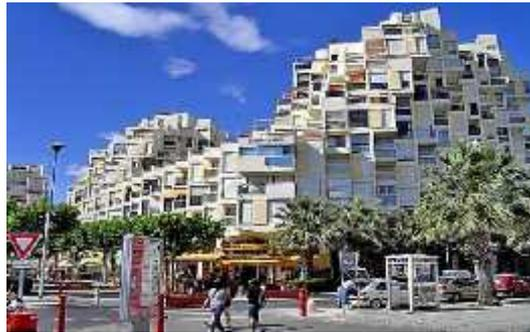
Figure36: Pare-soleil horizontaux permettant l'ombrage des façades orientées au midi, ils sont inefficaces sur les façades orientées à l'Est et à l'Ouest.
