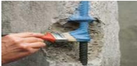
Figure40:Utilisation de peinture hydrofuge contre la corrosion.
