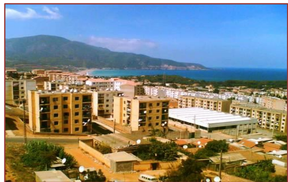
Figure 15 : L'organisation anarchique de la ville de Tipasa l'empêchera de profité de la vue sur la mer.URL : http://dz.geoview.info/vue_de_la_ville_tipasa_par_les_batiments,47
