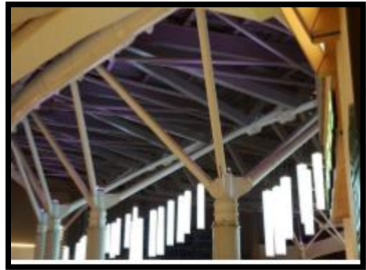
Figure106 : structure métallique d'un bâti
