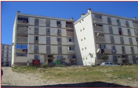
Figure 14 : Une bâtisse d'une cité a Bejaia qui est une ville littorale qui semble aux bâtisses des villes internes.URL : http://iskkan.com/photos/proprietes/miniatures/DSCN0584_1941_1.jpg
