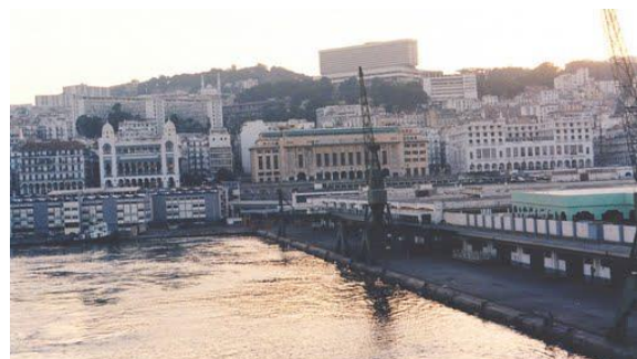
Figure55 : vue sur la façade maritime
