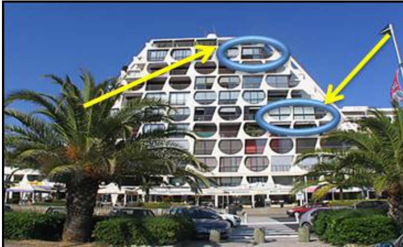
Figure 10 : De grandes ouvertures pour profiter de l'éclairage naturel et aussi de l'aération. (Source. URL: https://www.google.dz/search?q=la+grande+Motte+Languedoc+%E2%80%93+Roussillon . Complétée par les auteurs).
