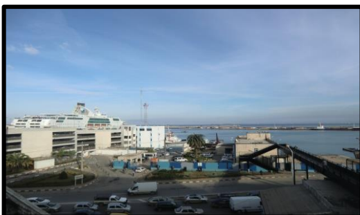
Figure 87; La gare maritime internationale d'Alger
