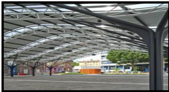
Figure108 : exemple d'une structure métallique URL : https://www.google.dz/search?biw=1366&bih=662&ei=yCYQOWJZKusAfw4q=structure+métallique
