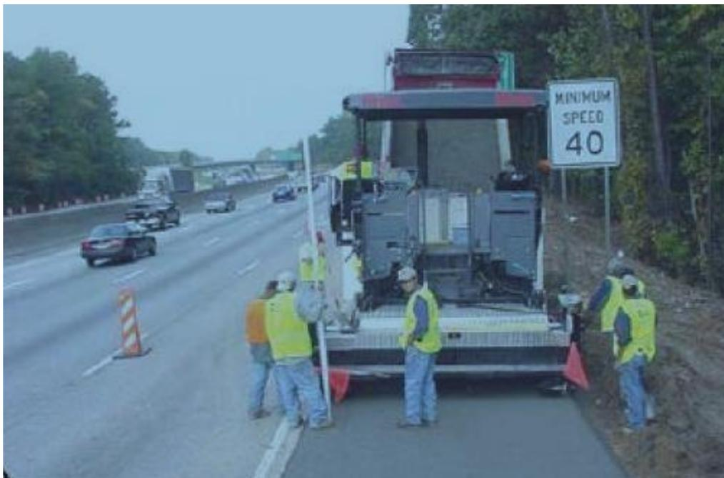
Figure I. 6 : Mise en place du BCR en pavage – Atlanta USA [12]
