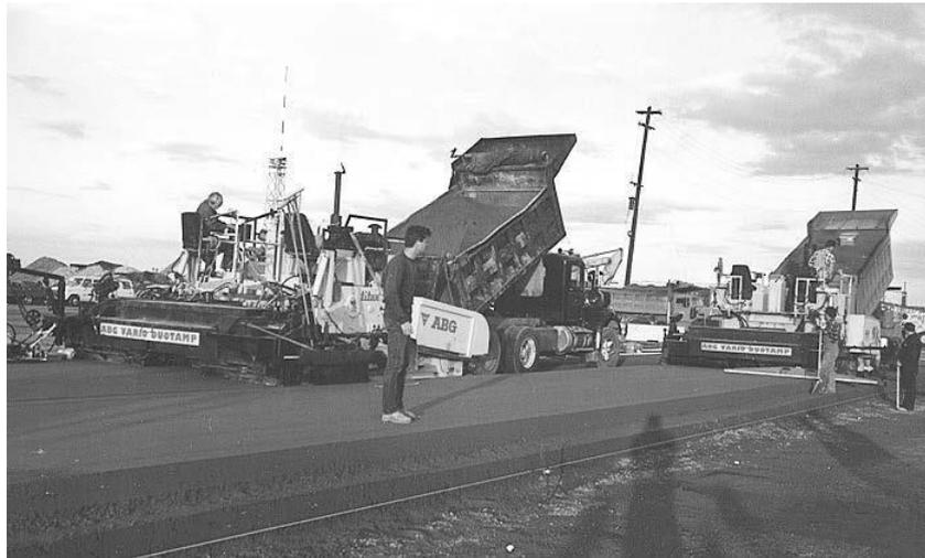
Figure I. 2 : Mise en place d'un BCR routier ACI Comimittee 2001 [4]
