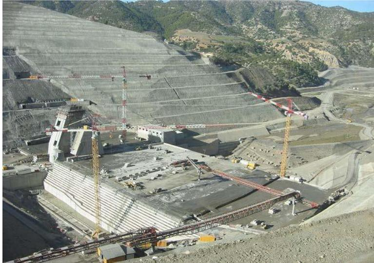
Figure I. 4 : Barrage de Koudiat-Acerdoune en Algérie, pendant la construction [5]
