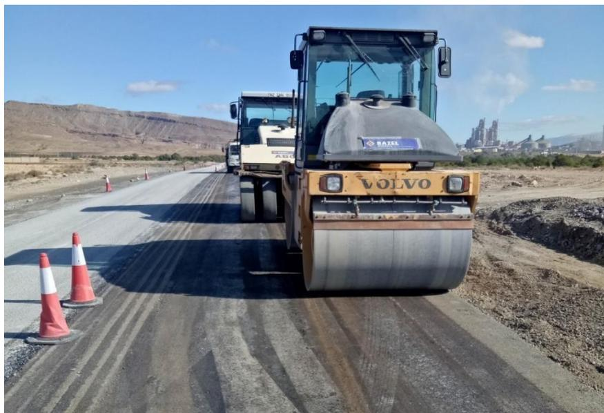
Figure I. 3 : Mise en place d'un BCR routier (route HAMMAM DALAA).
