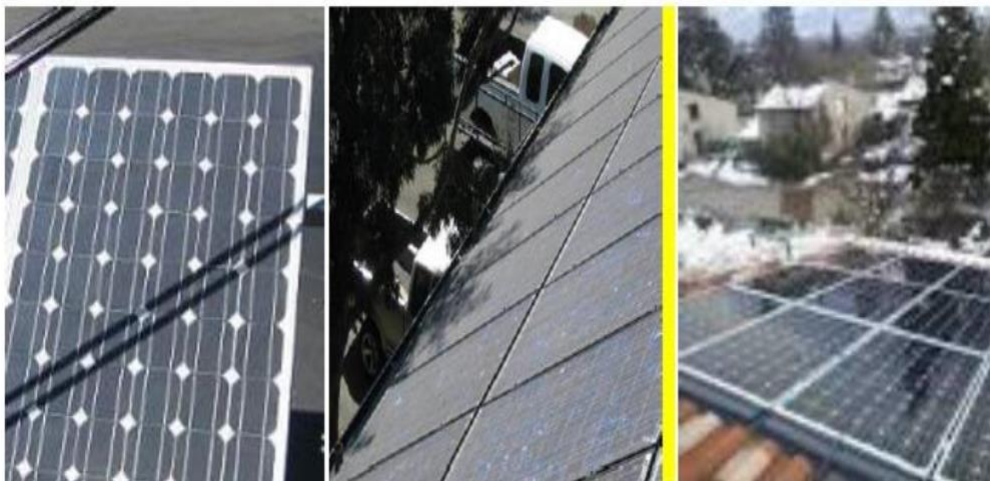
Figure II.7. Défaut de l'ombrage partiel. [18]
