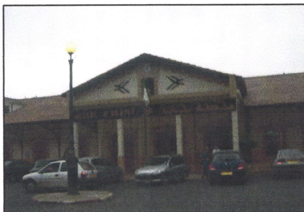
Figure 73 : gare ferroviaire de Bejaïa /source : Photo prise par le groupe.
