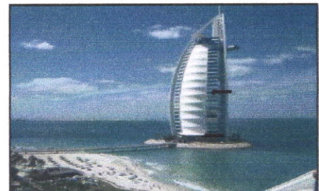
Figure36 : Orientation du bâtiment source : www.SlidePlayer.fr
