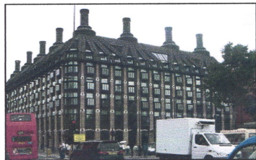
Figure 44 : Le séchage, assainir, aérer les bâtiments Source : www.smart city.com
