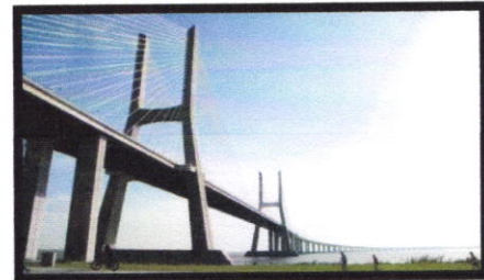
Figure 56 Câbles de retenue
