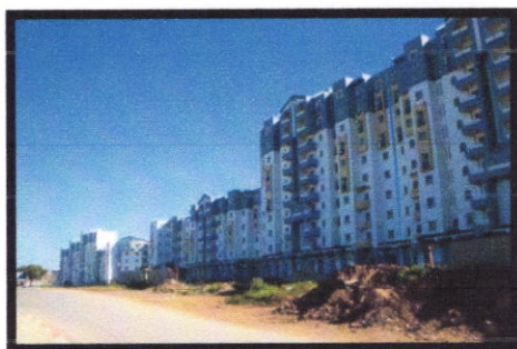
Figure 135 logements de Tipaza
