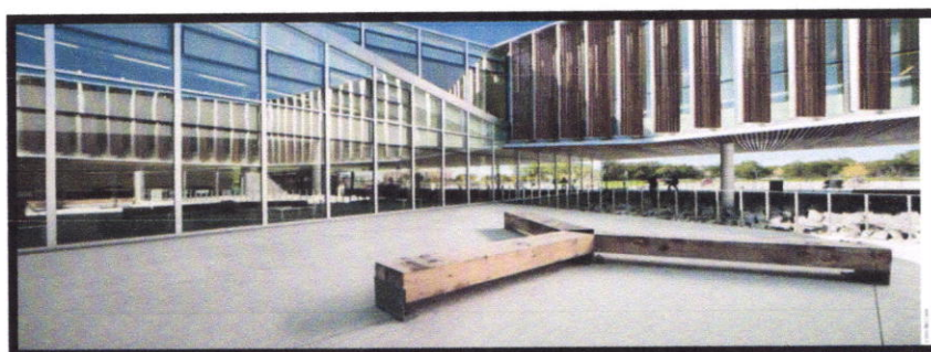
Figure.28 Vue à l'extérieur
