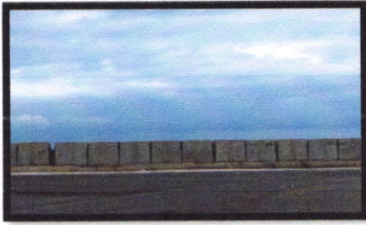
Figure 158 digue du port de Tipaza
