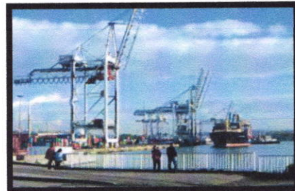
Figure 11 port de commerce de Havre
