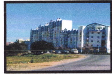
Figure 108 façades mal traitées
