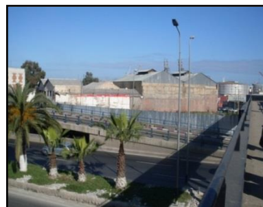
Fig.36. Les Hangars Src : auteur 2017
