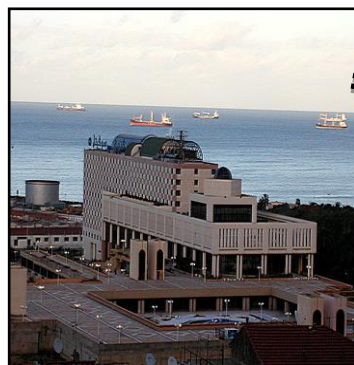
Fig.30. Hôtel Sofitel Src : auteur 2017
