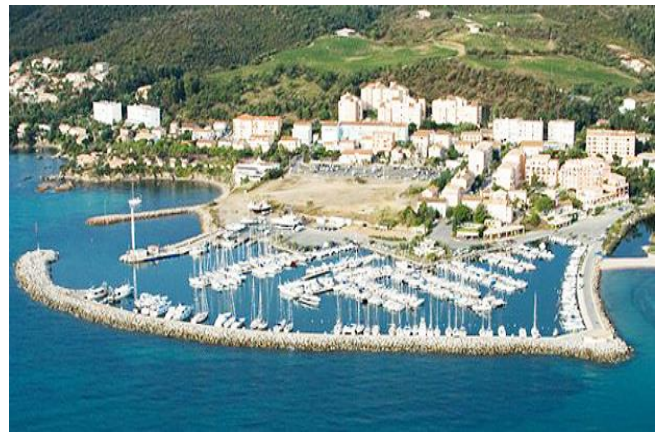
Fig.14. port de plaisance de le Havre
