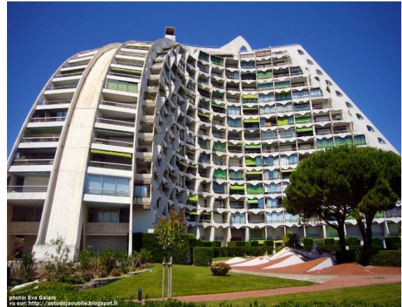
Fig.36. les l'utilisations des toitures inclinés
