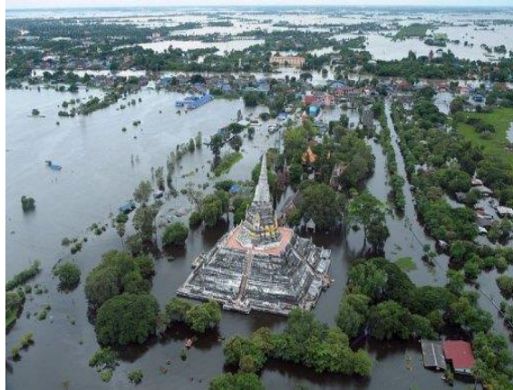
Fig.43.remontée des eaux « inondation »
