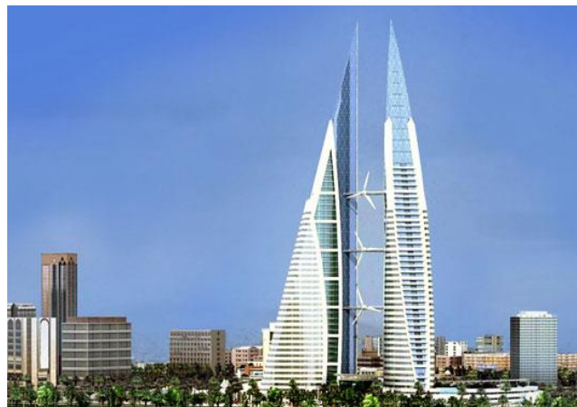
Fig.37. l'utilisation des éoliennes dans un équipement Bahrayn World Trade Centre pour profiter des vents
