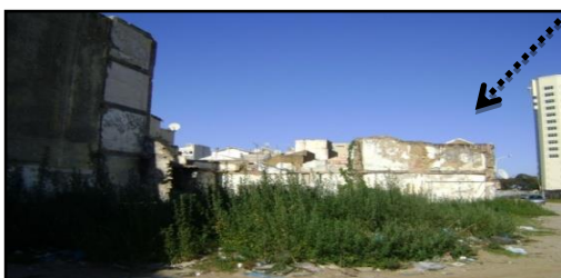
Fig.37. Habitat collectif (Rue Amar Achour)
