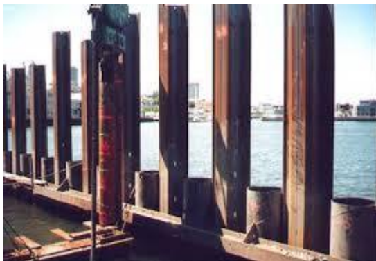
Fig 33: Les pieux de fondation. Une technique de construction front de mer .
