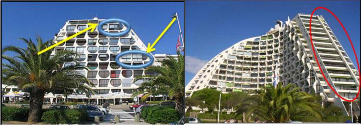
Fig 34 : De grandes ouvertures pour profiter de l'éclairage naturel et aussi de l'aération. (Source. URL: http://www.web-provence.com/autour/grande-motte-6.htm . Complétée par l' auteur)
