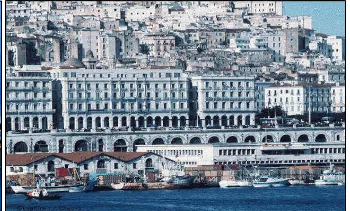
➤ Façade maritime d'Alger la blanche ..
