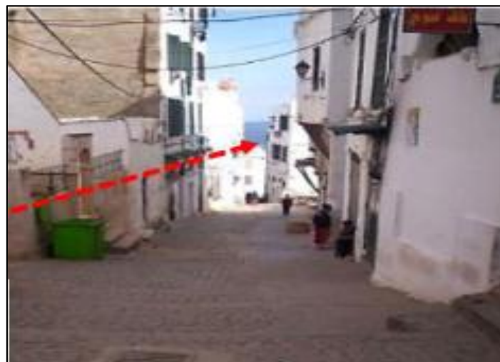
Fig09 : L'un des quartiers de la Casbah à Alger qui représente son développement perpendiculaire à la mer en épousant le terrain accidenté. (Source. Photo auteur)
