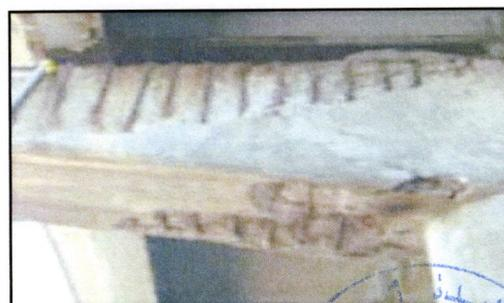
Figure1 : phénomène de corrosion d'un poteau en béton armé
