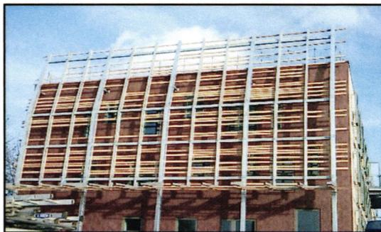
Figure2 : Pare-soleil horizontal permettant l'ombrage des façades orientées au midi, ils sont inefficaces sur les façades orientées à l'Est et à l'Ouest.
