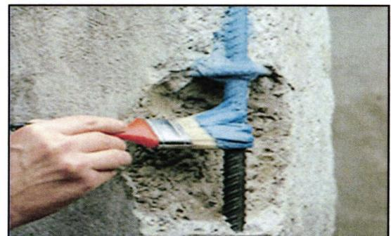
Figure2 : Utilisation de peinture hydrofuge contre la corrosion.
