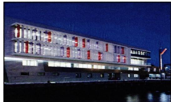
Figure3 : Pare-soleil vertical protège les murs extérieurs de l'ensoleillement direct permettant une ventilation par convection le long de la paroi extérieure du bâtiment.
