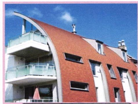
Fig.21 : Toit incurvé couvert de tuiles
