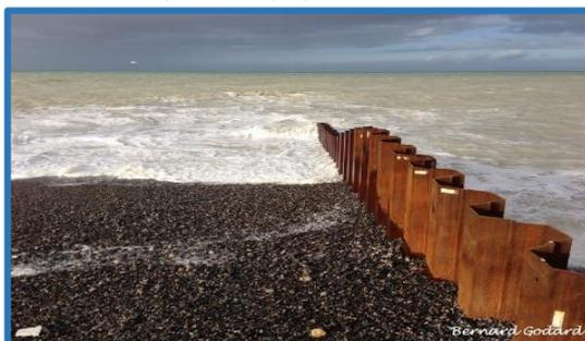
Fig65 : ouvrages transversaux
