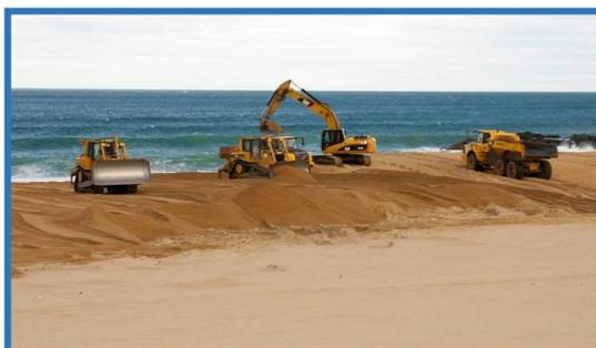
Fig62 : reprofilage mécanique
