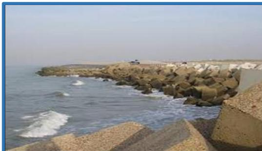
Fig63 : Les digues comme ouvrage longitudinal
