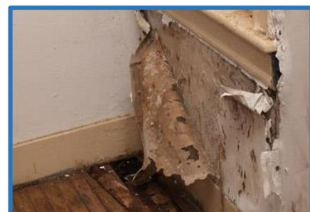
Fig53 : L'effet de l'humidité
