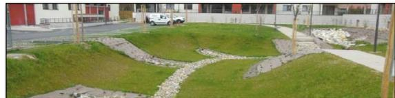
Figure I-12: Bassin d'infiltration.
