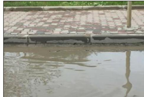
**Figure 02 : Chaussée non poreuse à Bab Ezzouar**
