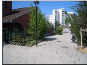
Figure I-25 : Les revêtements perméables
