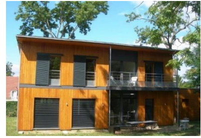
Figure 98: La Maison passive France. Maison individuelle isolée ou jumelées Ile de (www.construction21.org).
