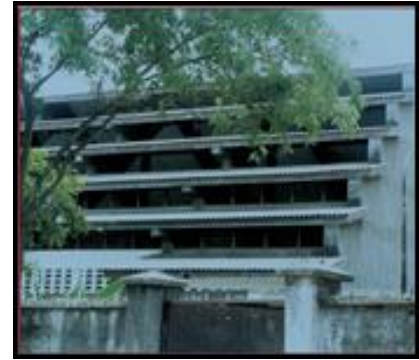
Figure 59 : toiture au vent de l'Eglise Saint Augustin de Kinshasa Architect, P.Dequeker source (Liebard A. De Herde. A, 2005).
