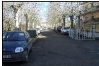
Figure 115 : Voie tertiaire vers le site cote sud-ouest source auteur
