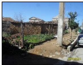
Figure 120 : l'habitat individuel au sud du site en mauvais état.
