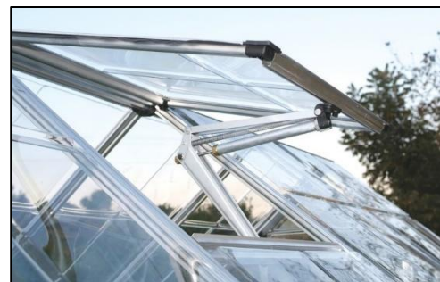
Figure 166: système d'ouverture d'atrium /source www.glassskylights.com
