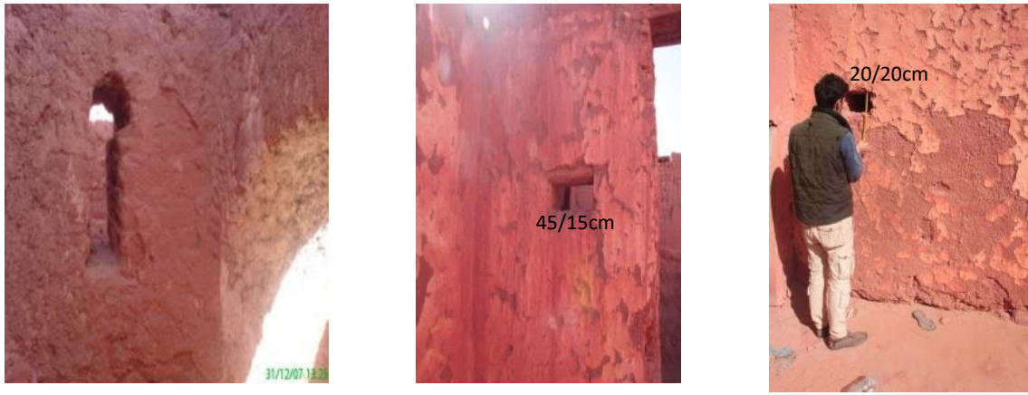
Figure 66: les fenêtres au niveau de ksar/source : auteur.
