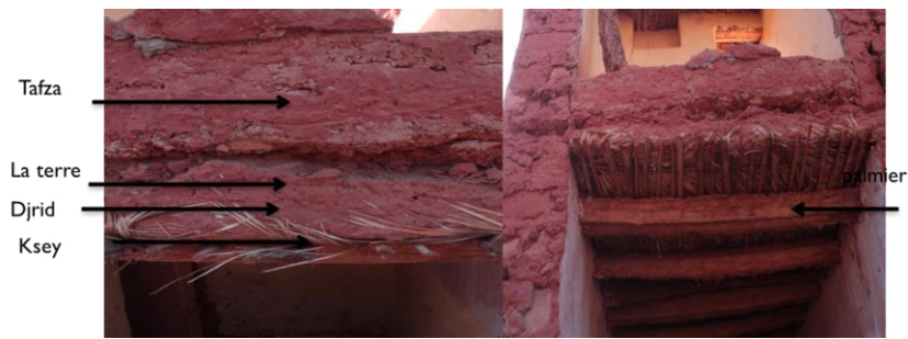
Figure 68: détails de plancher timimounienne/source : auteur.
