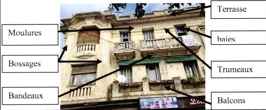
Figure22 : traitement d'une façade du BV Laichi. Source: Auteur.
