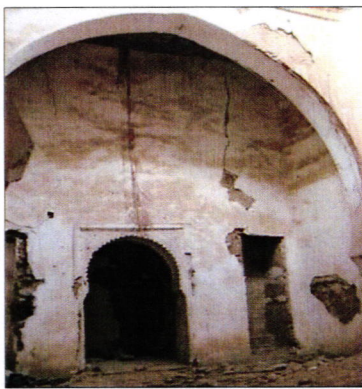
Fig 20 : Arc brisé outrepassé Source : photos personnelles
