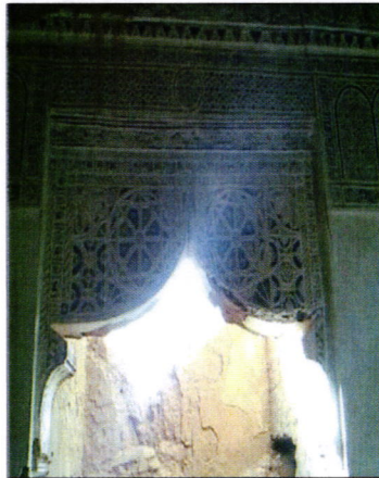
Fig 29 : Arc brisé Source : photo personnelles
