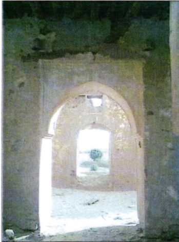
Fig 26 : Arc brisé outrepassé Source : photo personnelles
