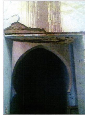
Fig 30 : Arc brisé outrepassé Source : photo personnelles
