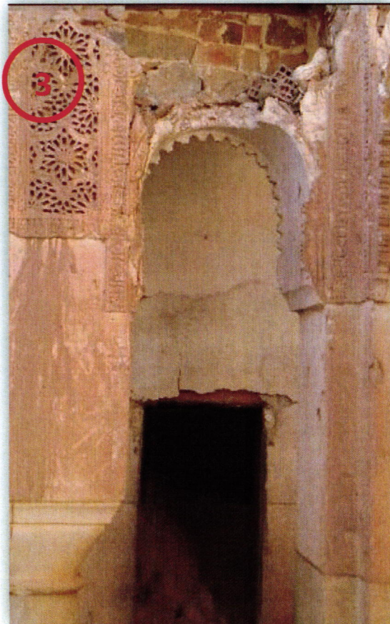
Fig 77 : arc polylobé Source : photo personnelle
