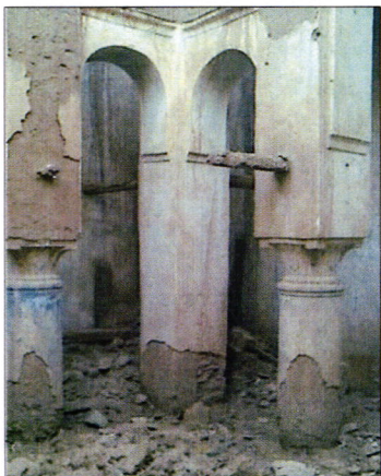
Fig 32 : Arc plein cintre outrepassé Source : photo personnelle
