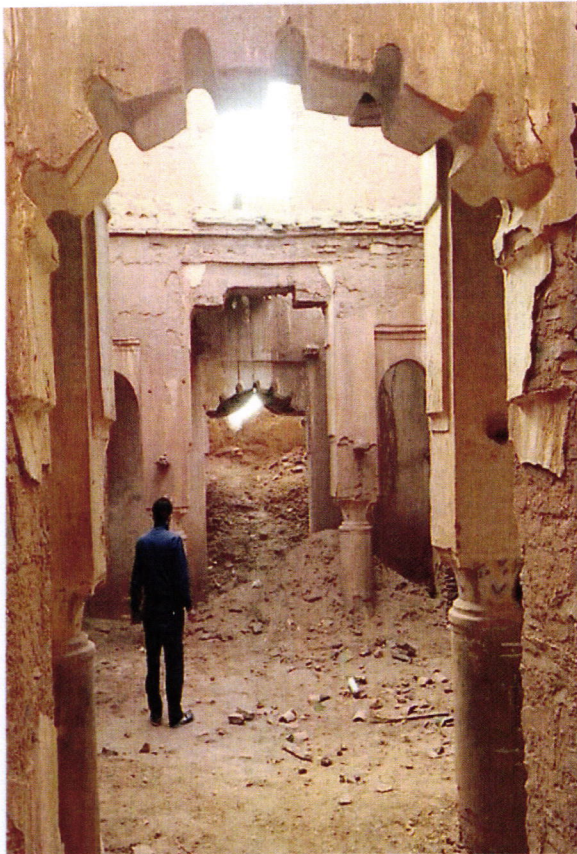
Fig 94 : arc polylobé Source : photo personnelle
