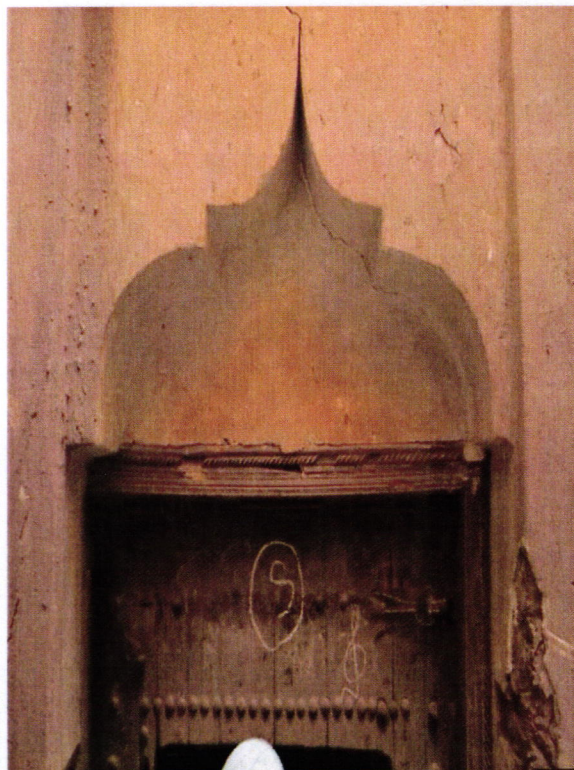
Fig 96 : arc recticuviligne Source : (photo personnelle)
