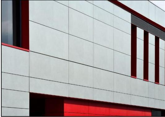
Figure II.76. Revêtement en panneaux d'Aluminium.
