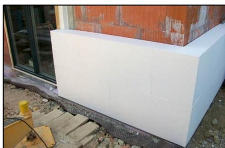
Figure I.5. Isolation d'un mur de l'extérieur.
