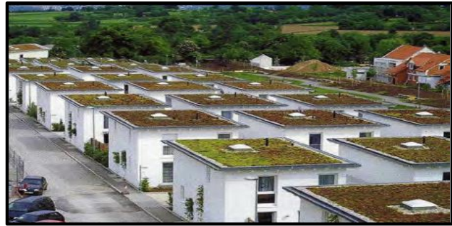
Figure I.74 : Multiplication des toits végétaux comme moyen de réduction de l'effet d'ICU (Source : Leroux.F, 2005)
