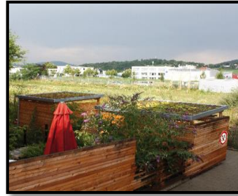
Figure I.48 : toiture végétalisée sur bâtiments, quartier Rieselfeld
