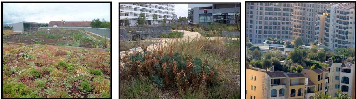
Figure I.70 : Toiture végétale extensive //Toiture végétale semi-intensive, //Toiture végétale intensive (Source : impacts du végétal en ville Septembre 2014)
