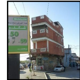
Figure I.17 : Pas d'alignement de façade sur la voirie (source : auteur)
