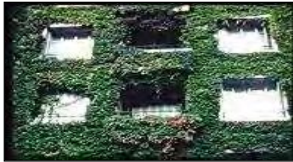
Figure I.39: Traitement de la façade OUEST (Source : www.arbreurbain.com)
