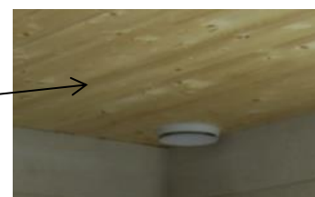
Figure 171:Les bouches du puits (source: http://www.fiabitat.com/dimensionner-un-puits-canadien/ )
