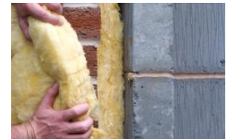
Figure 20:isolation source ( http://habitat-bulles.com/7-elementes-pour-une-maison-bioclimatique/ )
