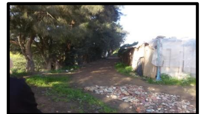
Figure 83: Habitat précaire source auteur
