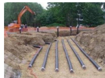
Figure 198 : la canalisation source http://www.sarllafon.fr/public/documents/PAGE%20PUITS%20CANADIEN.pdf
